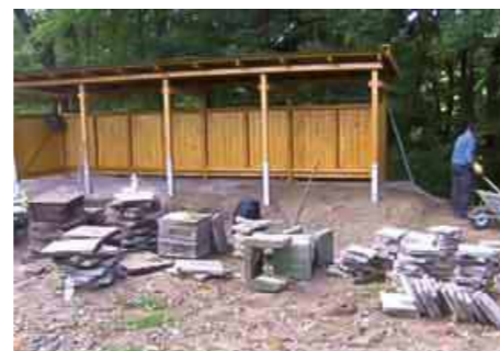
Arbeiten zum Bau eines Unterstands im Rahmen der zweiten Erweiterung des Bogenplatzes „Auf dem Volke“ im Jahr 2011.
